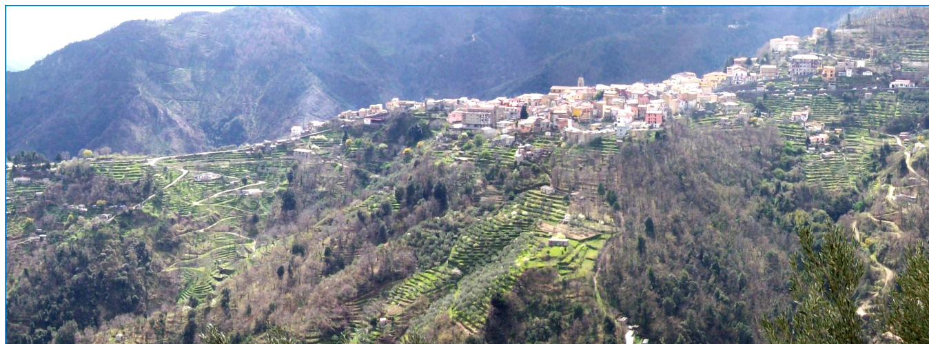
Pentone - Terrazzamenti dei versanti
